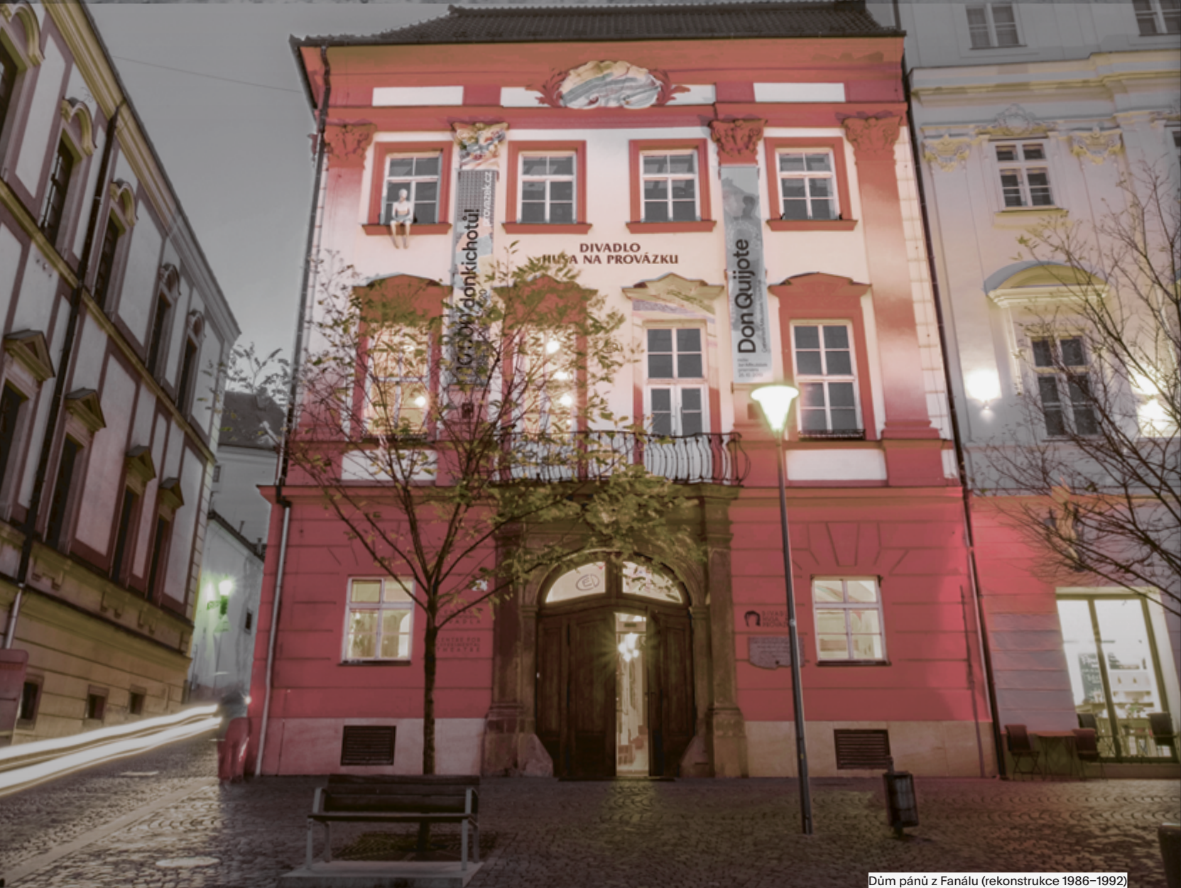
Dům pánů z Fanálu (rekonstrukce 1986–1992)
