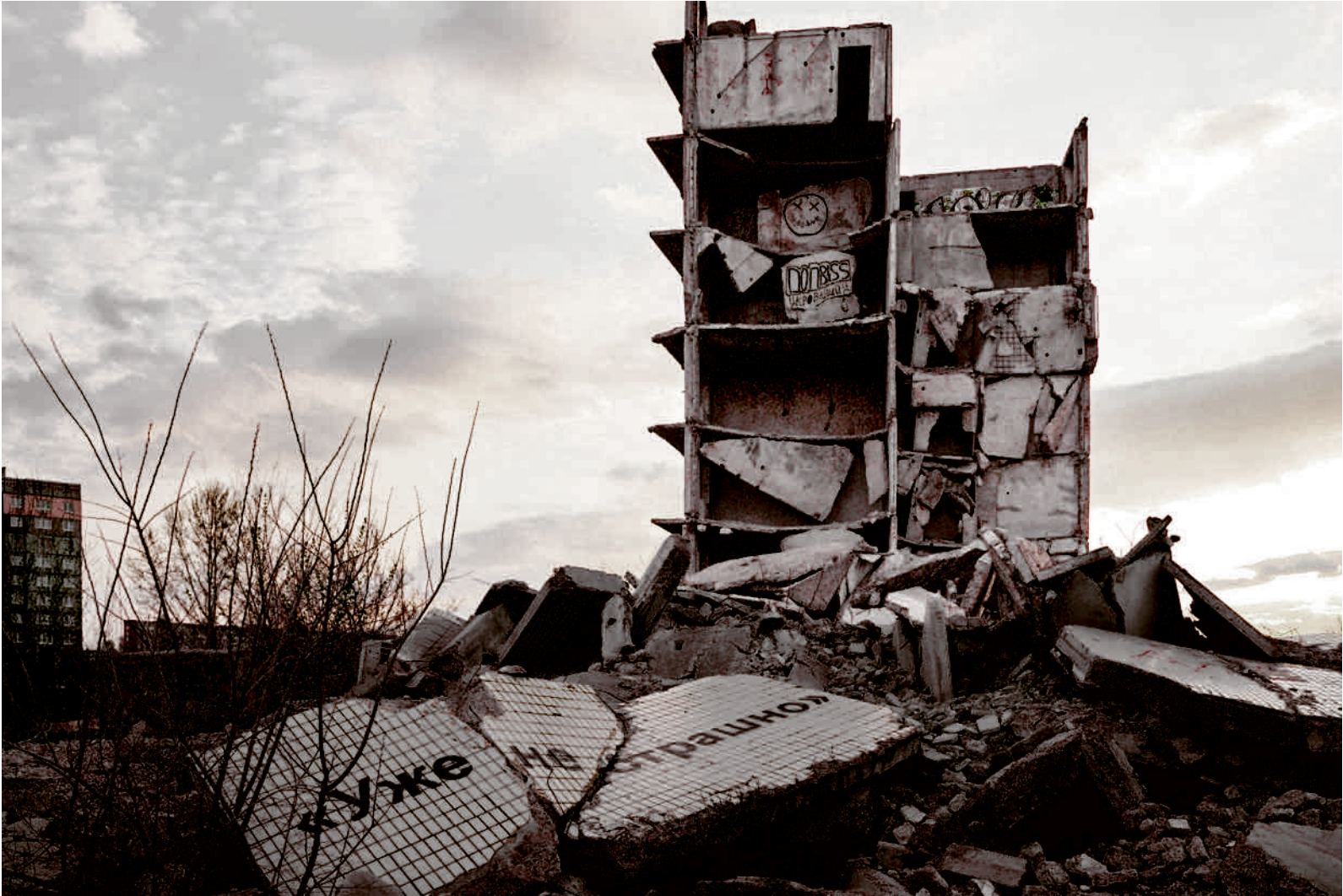
Sídliště v Kramatorsku přezdívané Čečna mělo podle plánu ubytovat uprchlíky z čečenské války. Projekt však nebyl dokončen kvůli chybějícím financím. V roce 2022 jeden z těchto nedostavěných domů zasáhla raketa. Kramatorsk, duben 2025
